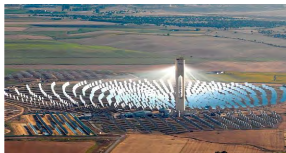
Figura 2.13. Colector solar por torre central con espejos o heliostatos [16].
