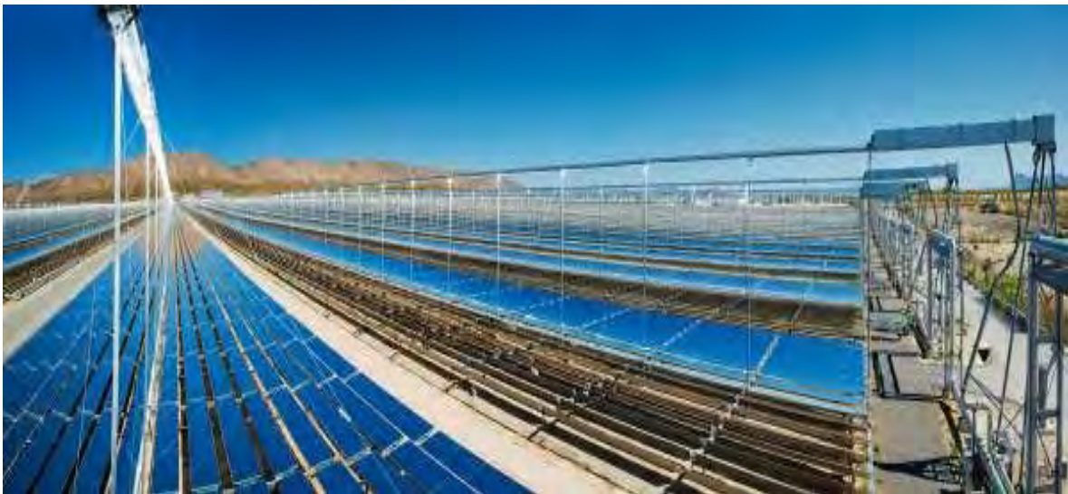
Figura 1.1. Funcionamiento de un colector solar tipo Fresnel de foco lineal y planta de energía termosolar Fresnel de Calasparra, España. [14]
