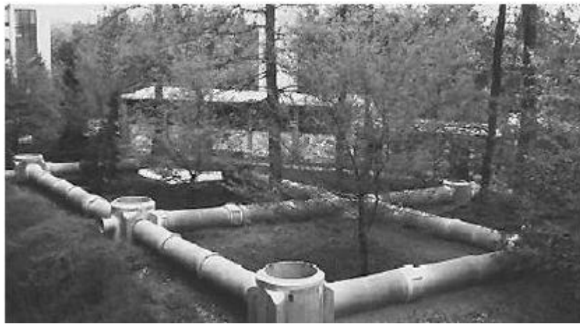
Figura 1. Inspección de los sistemas de tuberías de los servicios públicos.
