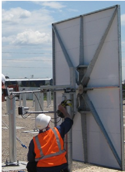
Figura 6. Ejemplo de un helióstato con actuadores lineales (Pfahl 2013).
