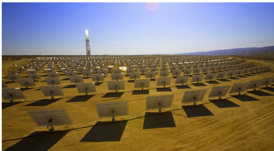
Figura 9. Campo de helióstatos centralizados. (Global NevadaCorp. 2011)
