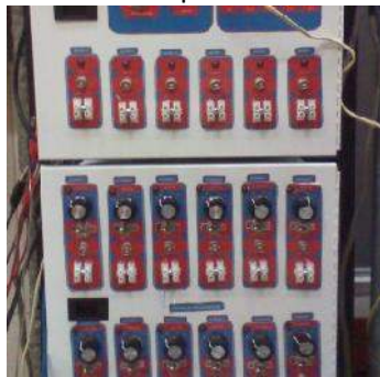
Figura 75.- Gabinete de entradas y salidas del robot
